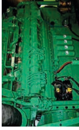
Un moteur de cogénération, qui permet de produire électricité et chaleur.
