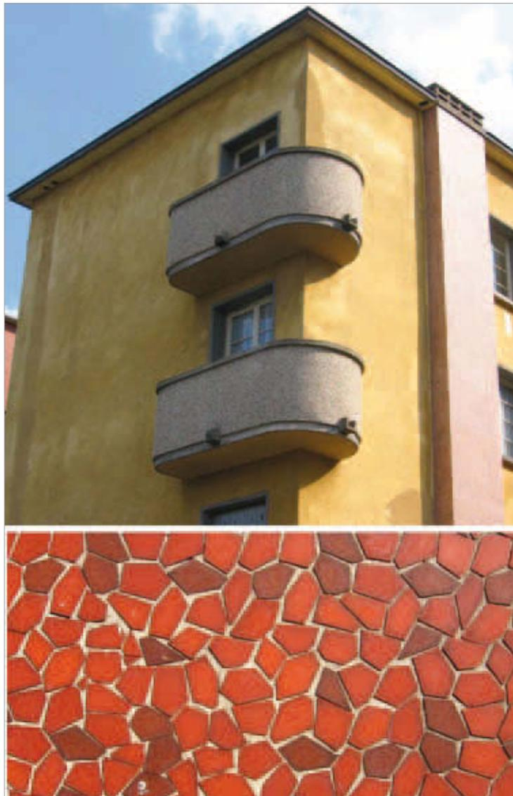
Fig. 12 : Vue rapprochée d'un pignon : murs enduits, revêtement des balcons en mignonnette, grès cérame sur les conduits de cheminées. En bas : détail du revêtement de céramique des rez-de-chaussées et des escaliers. Photos P. Gourbin.
