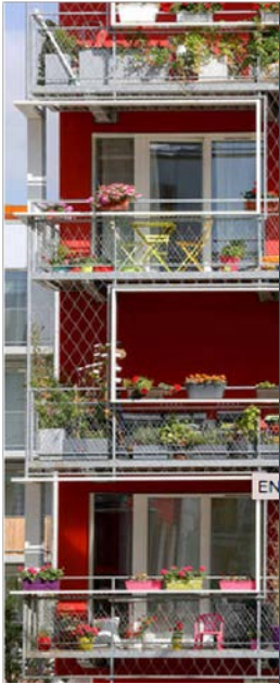
© Les CAUE d'Ile-de-France
